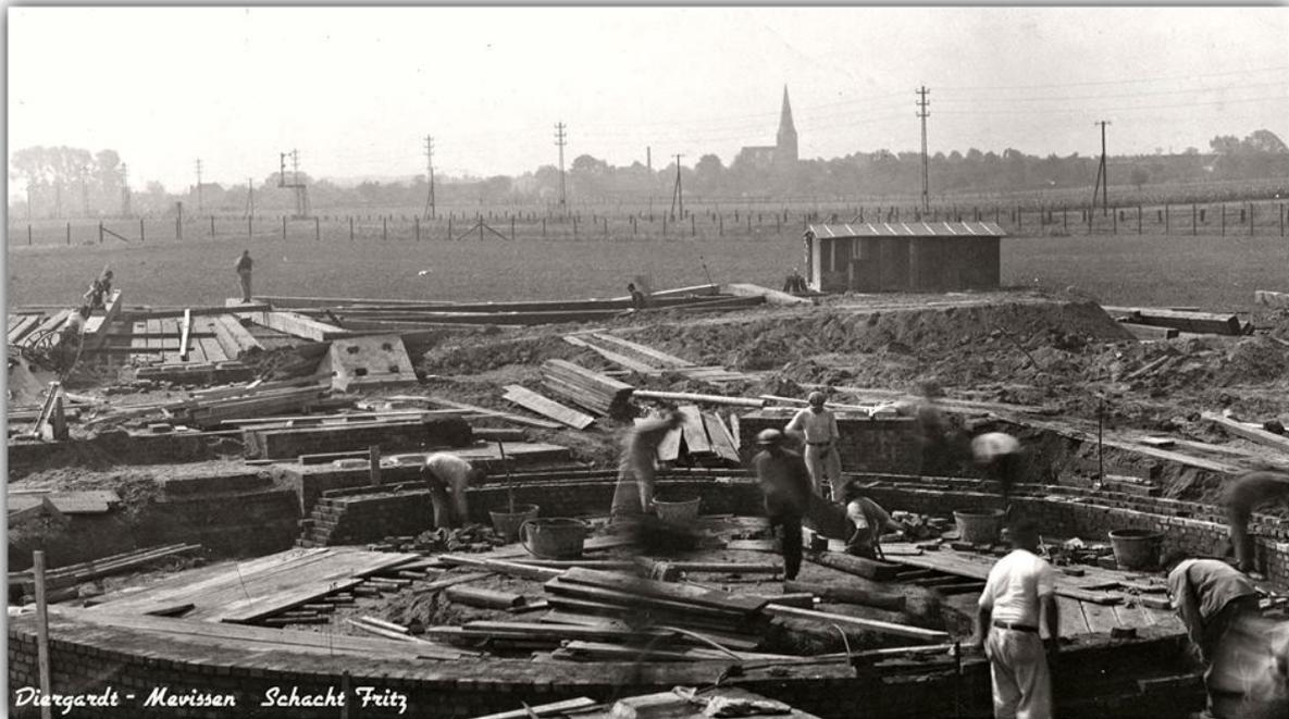
Abbildung 300 Schacht Fritz - Fundament für das Abteufgerüst<sup>448</sup>
