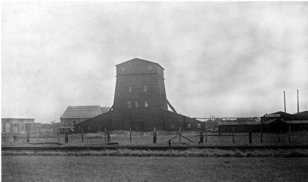
Abbildung 302 Abteufgerüst Schacht Rumeln, später mit Holzverkleidung<sup>261 448</sup>
