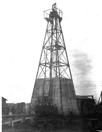
Abbildung 301 Bohrungen Gefrierlöcher für Schacht Rumeln<sup>261</sup>
